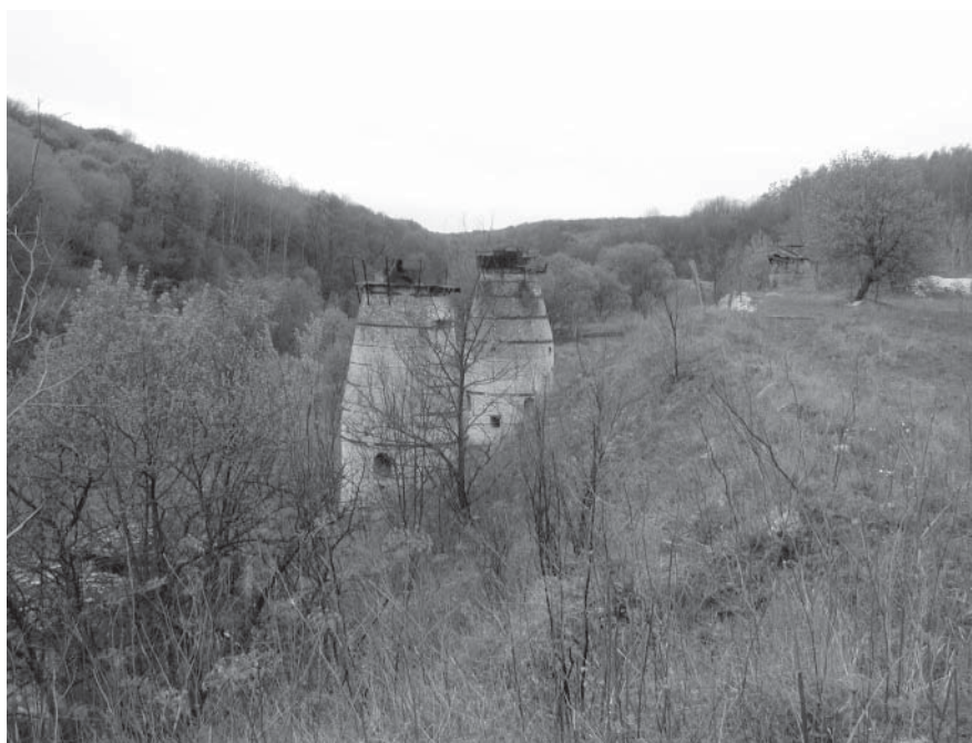
Печи для обжига для приготовления извести на Крейдянском месторождении мела (постройки 50 годов)
