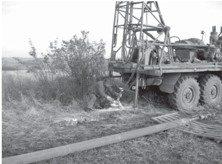
Промывка и тампонаж вышедших из строя водозаборных скважин
