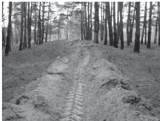
Устройство минерализованных полос и противопожарных разрывов
