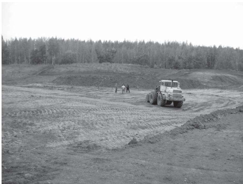
Рекультивация заброшенного глинистого карьера в г. Тим
