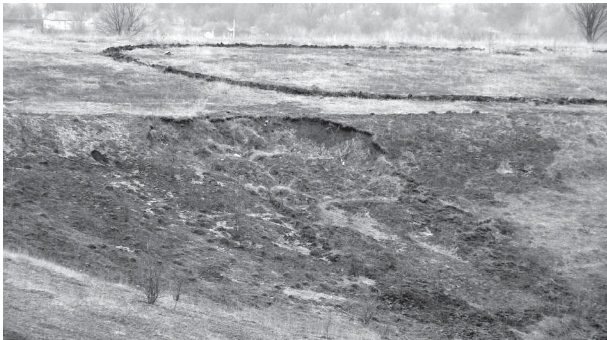
Оползневые процессы в районе д. Гuevo, Суджанского района.
