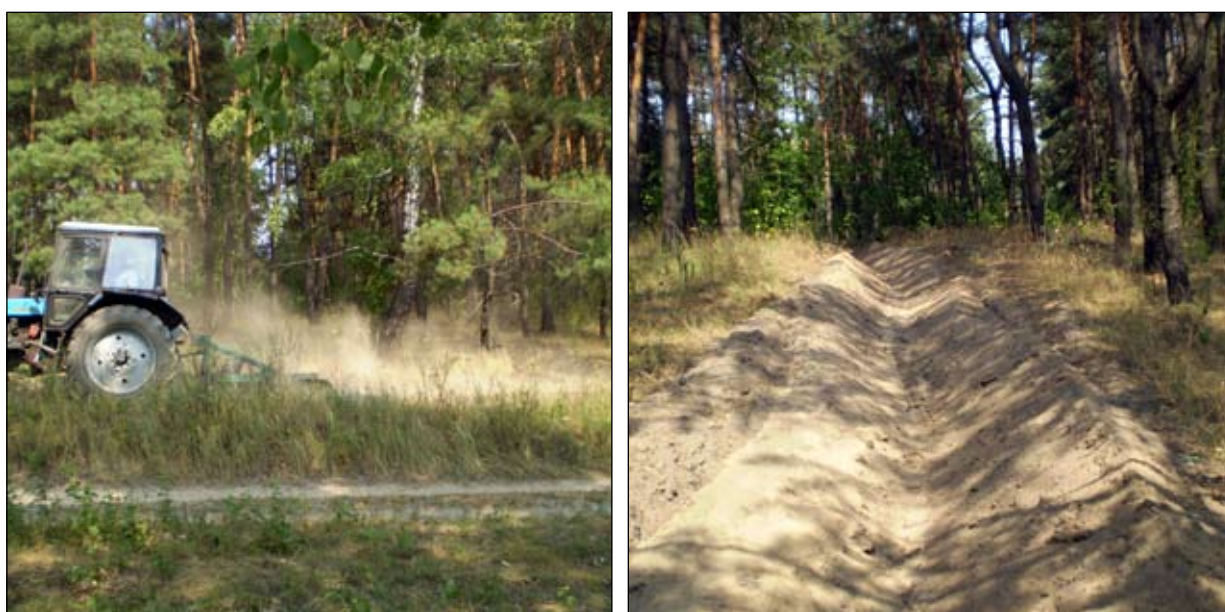
Рисунок 2.4. Устройство минерализованных полос
